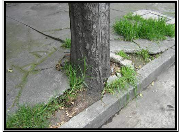
Fotografía 13 vereda destruida por la acción del desarrollo de las raíces
