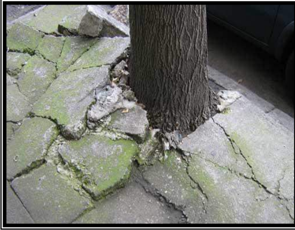
Fotografía 13 vereda destruida por la acción del desarrollo de las raíces
