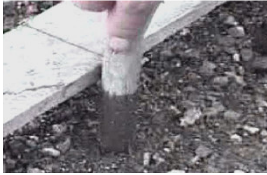
FOTOGRAFIA 4. Realización de hoyos con una herramienta de mano
