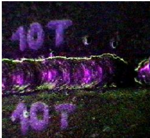
Figura 14: Fisuras alrededor del cordón (vista con Partículas magnetizables).
