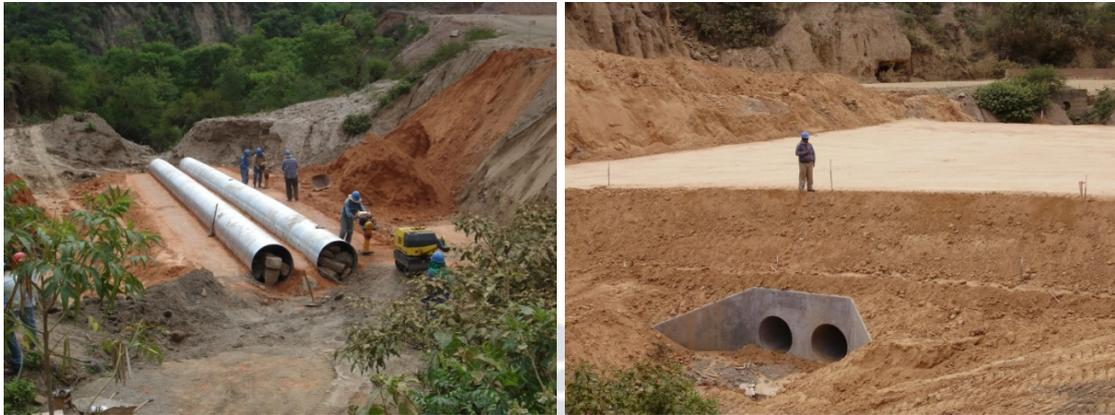
El Control Geométrico se ejecutaba replanteando la ubicación horizontal con la Estación Total del eje de la estructura y el control de las cotas utilizando el nivel de ingeniero, el registro y aprobación en función de la siguiente planilla del **Grafico N° 20**.
