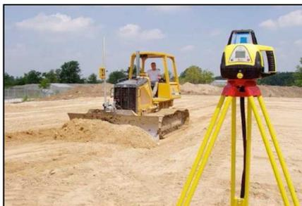
También existen los NIVELES LASER. Suelen ser niveles automáticos, pero el operador no mira a través de ellos, sino que estos emiten un rayo láser visible o no. Los de rayo visible se suelen utilizar para marcar niveles sobre una pared, muro, a
