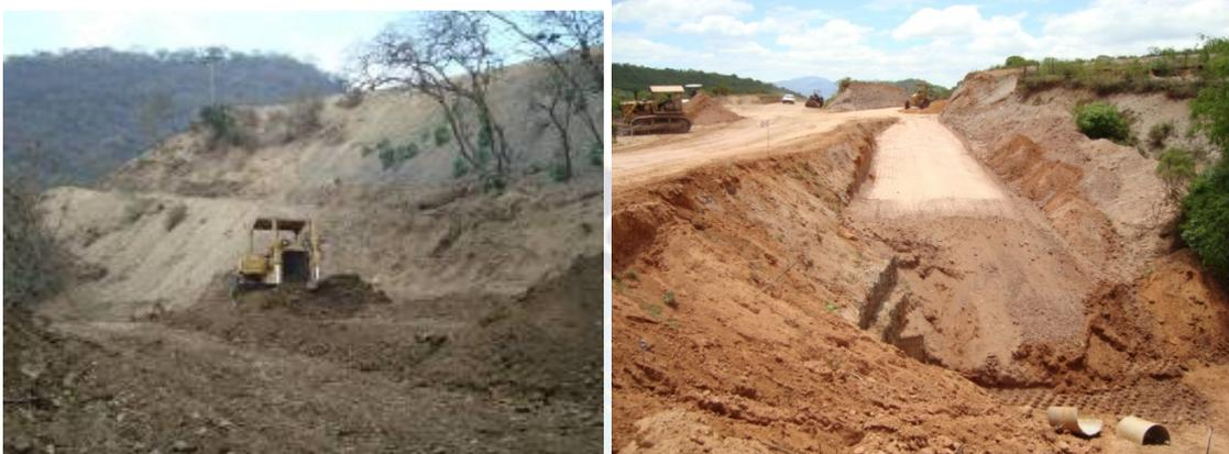
Los terraplenes son segmentos de la carretera conformados con materiales provenientes de cortes o préstamos, como se muestra en la **Imagen N<sup>o</sup> 16**, dentro de los límites de las secciones de diseño, que definen el proyecto de la carretera
