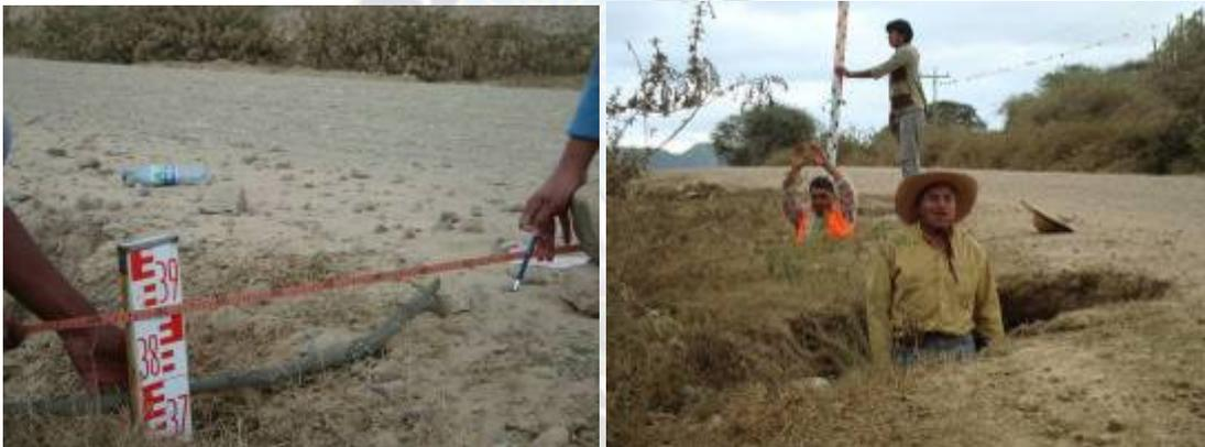
Se realizaron levantamientos topográficos adicionales en lugares donde se construyeron muros de contención y protección del terraplén, trabajos realizados paralelamente a los controles geométricos propios de la obra.
