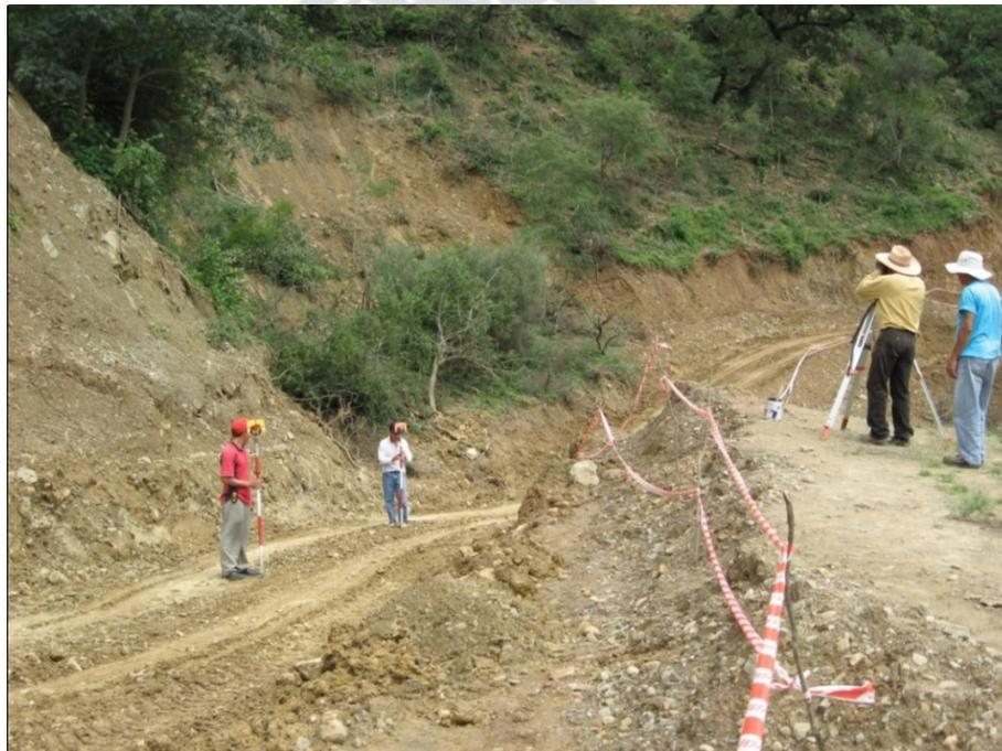
En este sector se tuvo que realizar un levantamiento a mayor detalle considerando una franja alta que llegaba a una altura de 70 m, la metodología empleada fue por radiación de puntos.
