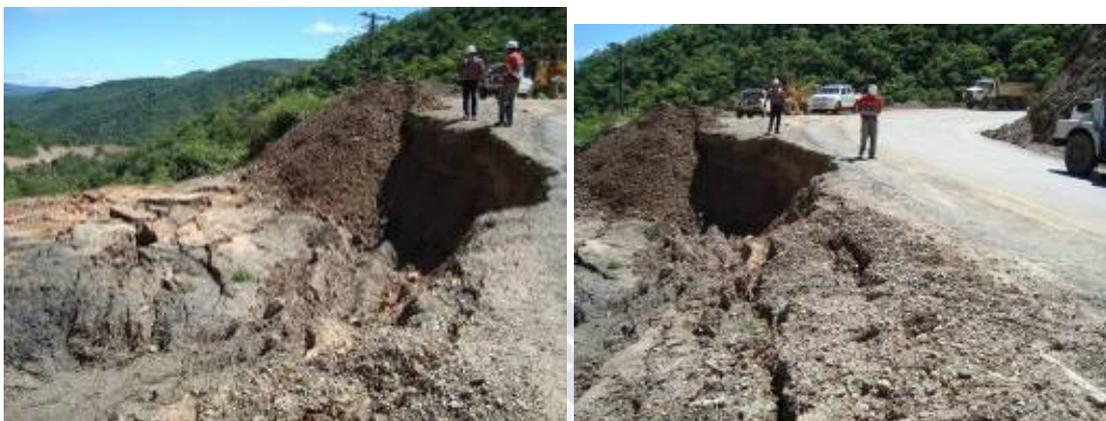
Luego de realizar una evaluación técnico-financiera del acontecimiento, vio por conveniente realizar una variante, desplazando el eje de la carretera hacia la ladera superior, entre las Prog. Km 11+580 al Km 11+700, de tal manera, que se pueda asegurar la estabilidad de la nueva plataforma, alejándose del borde.
