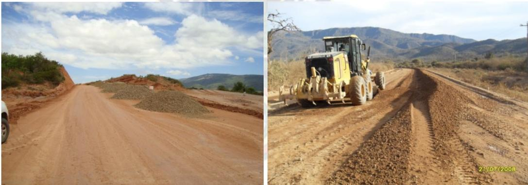
Esta actividad consistió en la explotación, procesamiento, acarreo, colocación y compactación del material aprobado para la capa sub base, construida sobre el terraplén de la carretera (subrasante), de acuerdo con las especificaciones Técnicas,
