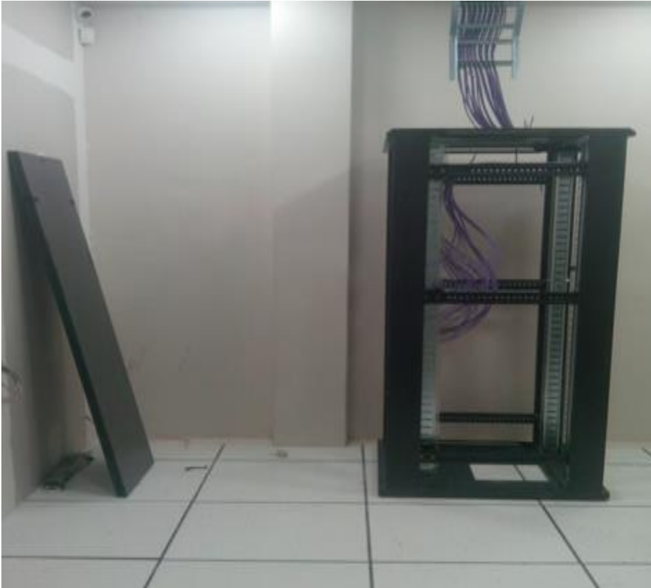
Figura N°4.38 Rack con la llegada de cables para cámaras Fuente : fotografía tomada por el autor, ambiente rack
