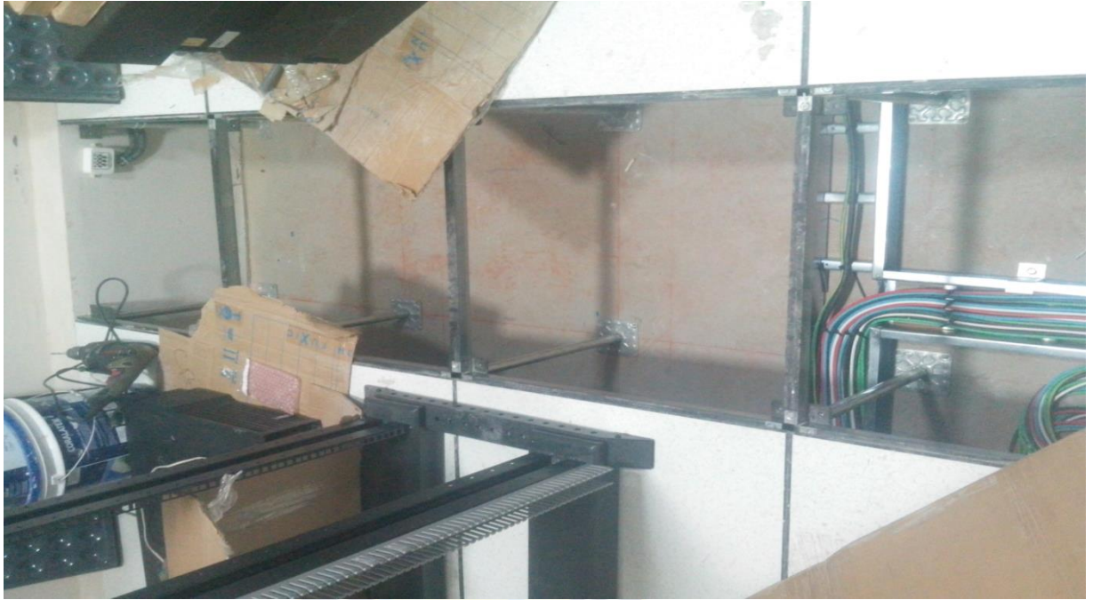
Figura N°4.5 Esquema de cableado por escalerilla Fuente: fotografía de piso técnico, ambiente racks, tomada por el autor
