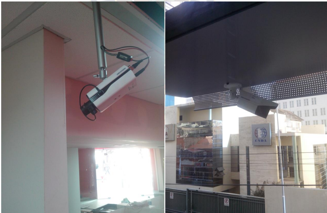
Figura N°4.42 Cámaras tipo bala interior y exterior Fuente : fotografía tomada por el autor
