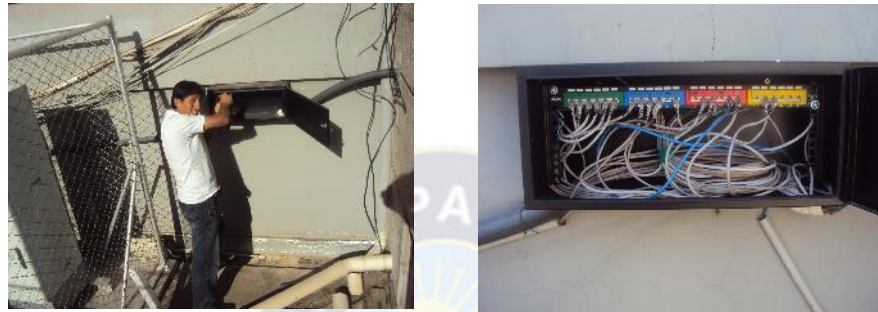
Figura 3.21 Colocando caja del Patch Panel y en la derecha la caja ya terminada
