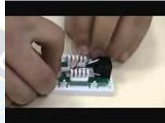
Figura 3.8 instalación de los cables en el keystone
