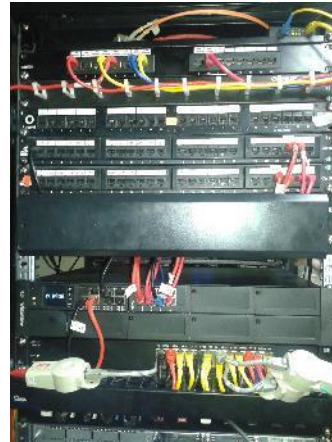
Figura 3.25 Correcciones hechas al cableado de las dos anteriores figuras
