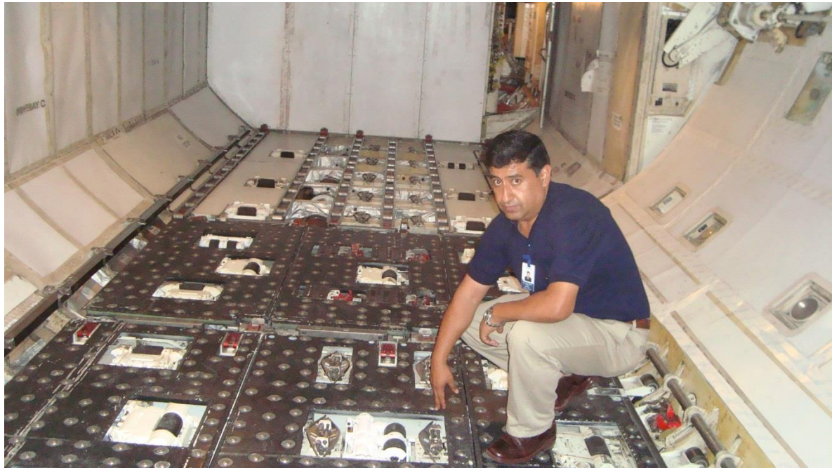
Imagen 3: Inspección en rampa para verificar el estado de buzones de carga
