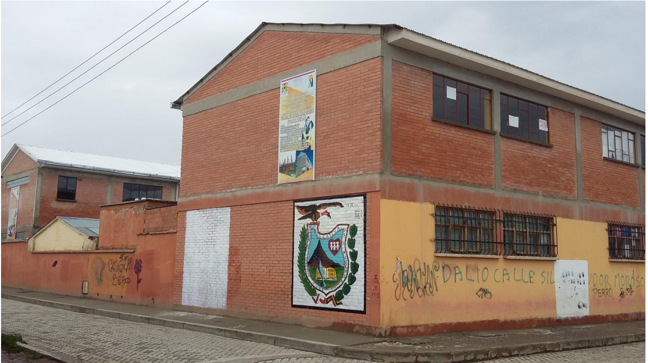
Foto 7. Vista lateral de la U.E. Amor de Dios
