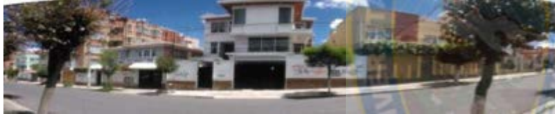
VISTA OESDE LA CALLE CUBA AL OESTE
