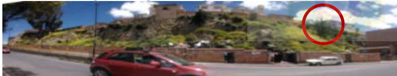
VISTA DESDE LA CALLE PARAGUAY AL PREDIO
