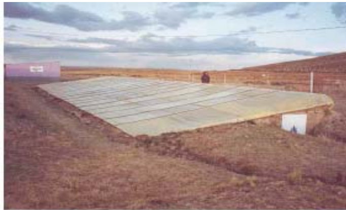
Fotografía 1: Vista externa del walipini.
