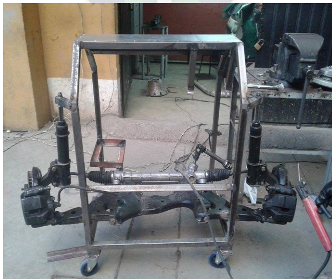
Figura 46. Proceso de soldadura de la estructura
