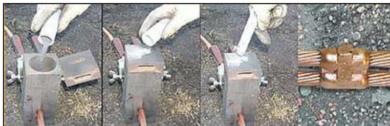
Figura 10 Proceso de soldadura exotérmica (fuente www.gedisa.com.ve )
