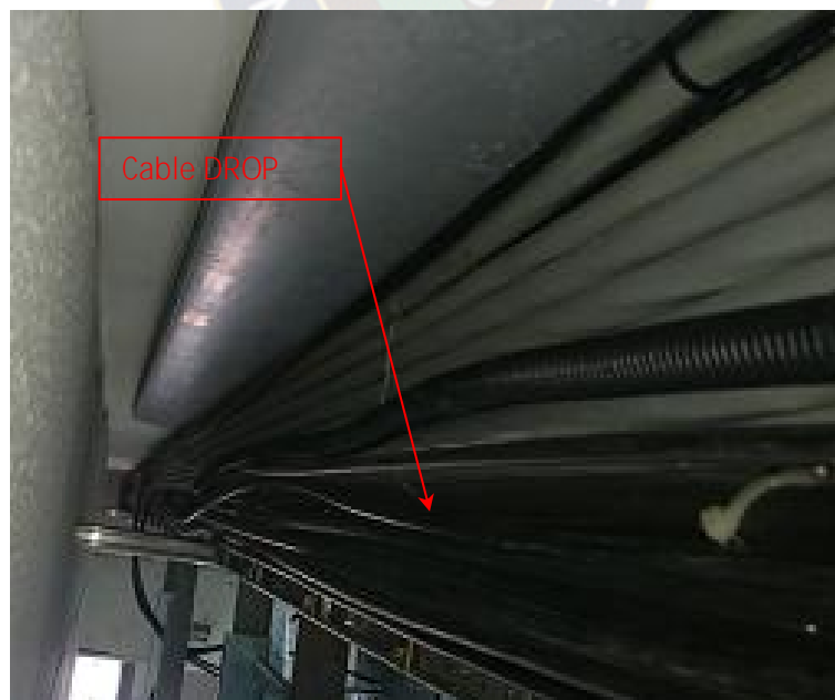
Figura 32. Tendido de cable drop en shaft
