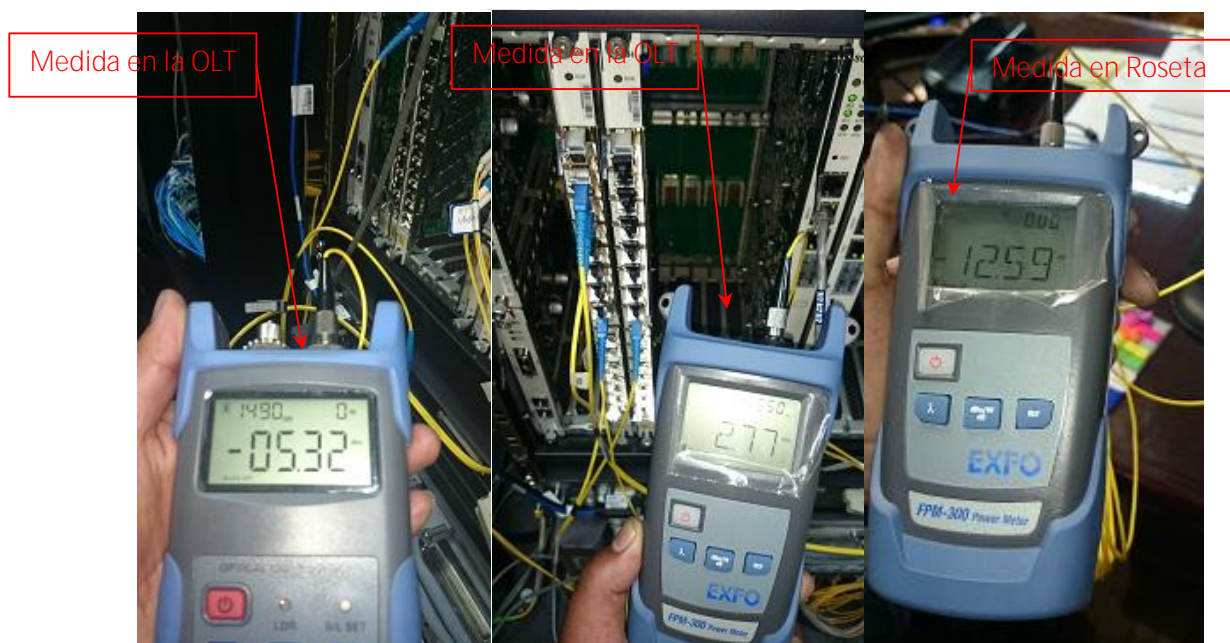
Figura 43. Medición con power meter en OLT
