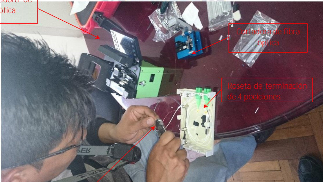
Figura 39. Empalme de la fibra
