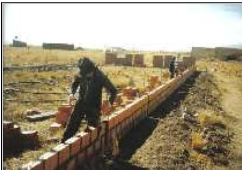
Gráfico 14 Construcción de carpa solar de 300 m 2
