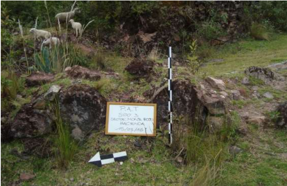
Figura 32 vista de una estructura colapsada de la Hacienda Huayrapata
