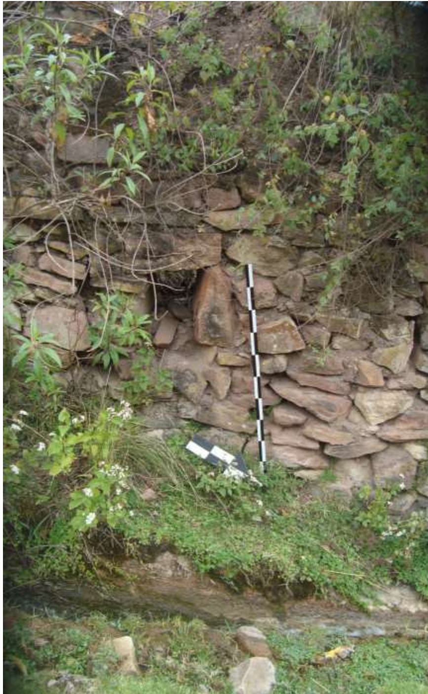
Figura 36: vista del canal que pasa por la estructura
