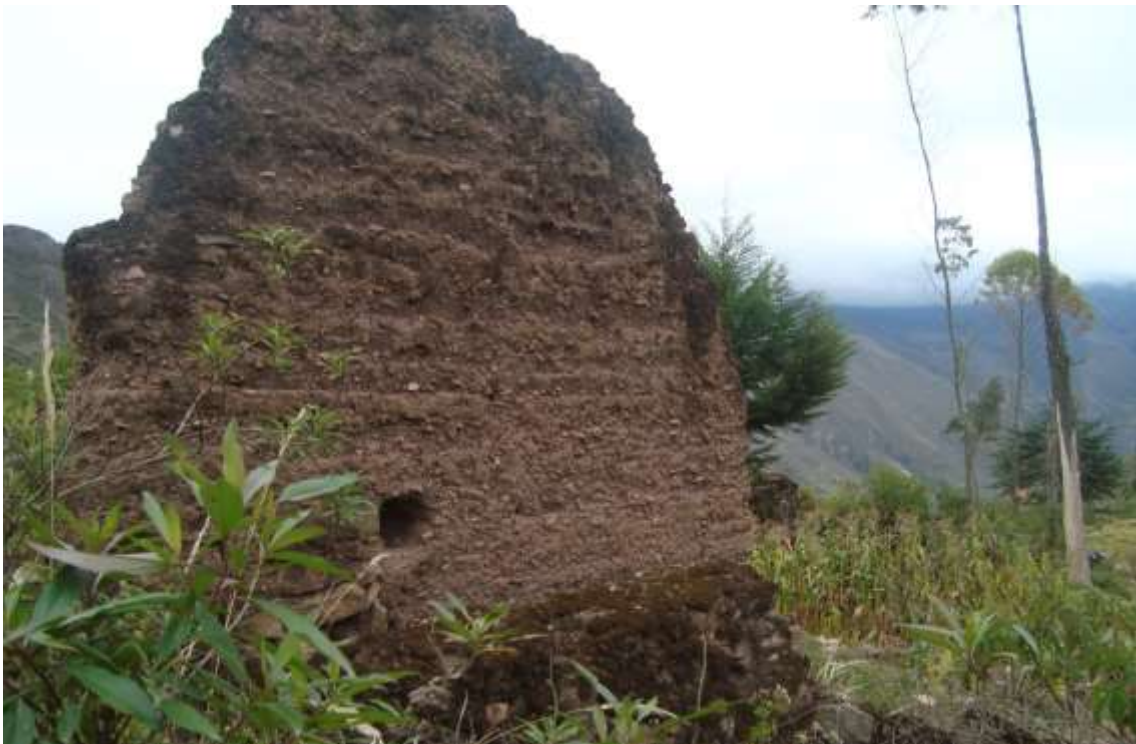
Figura 35: se observa el estado de conservación de los muros que todavía están en pie
