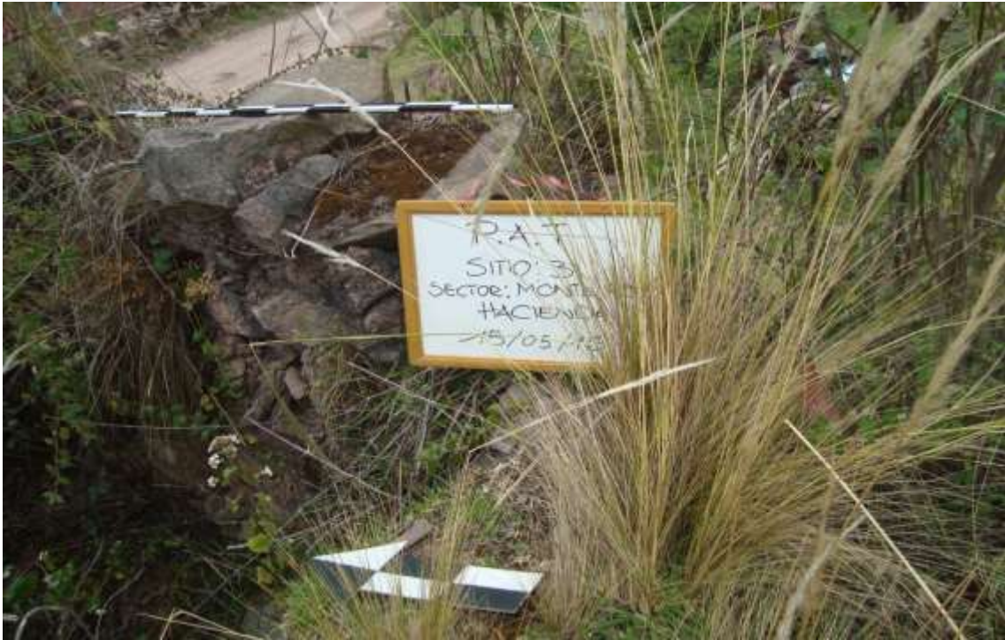
Figura 34: estructura colapsada sitio 3 Hacienda Huayrapata
