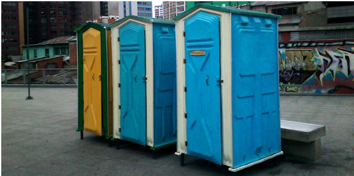
Ilustración 46: A pesar de ser un propuesta innovadora, la Plaza Camacho todavía presenta una serie de errores, en la ilustración vemos un conjunto de instalaciones sanitarias improvisadas colocadas al medio de la plaza, su permanencia es continua.
