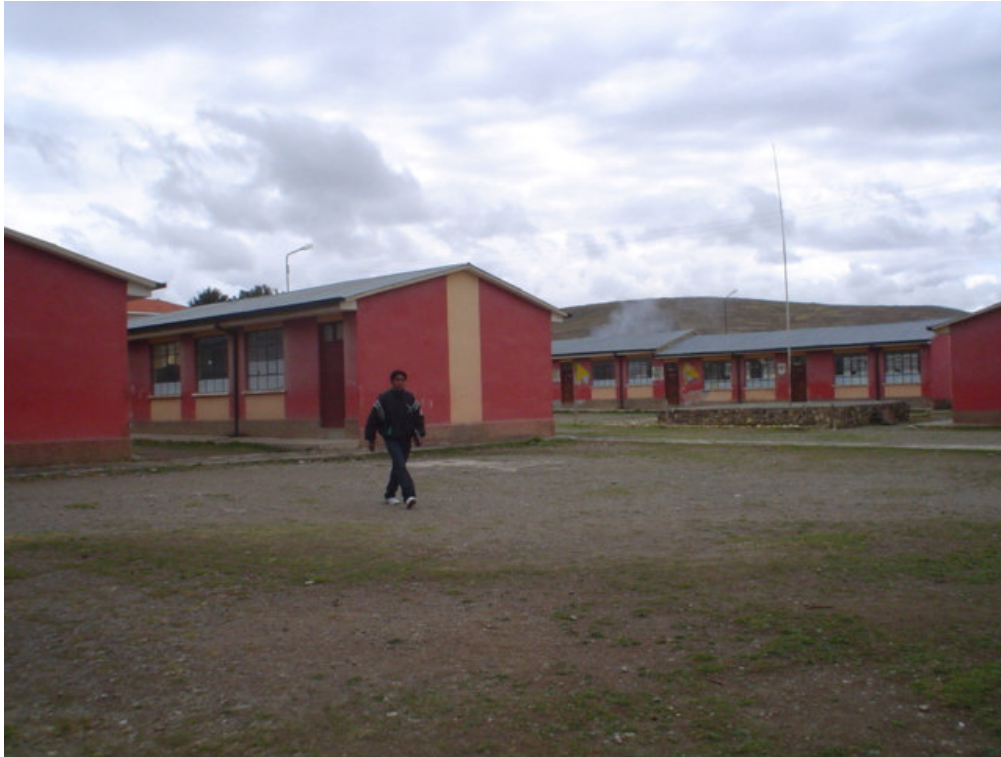
Fotografía 3. Vista general de las aulas
