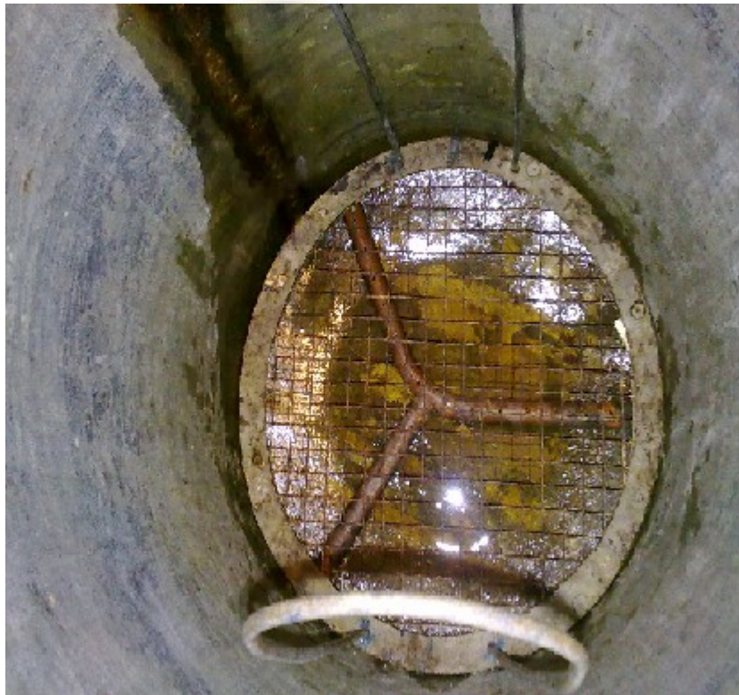
Figura 14: Distribuidor de vapor
