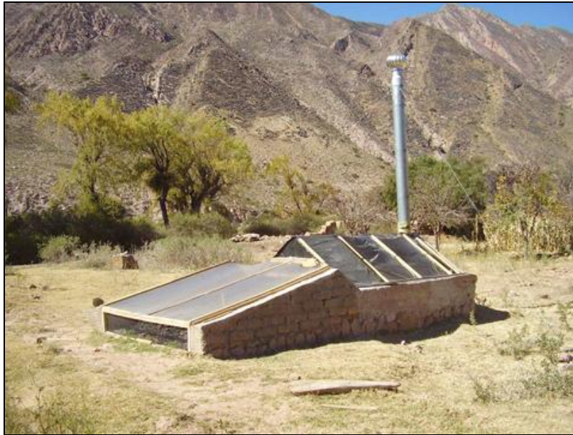
Foto 18. Secador solar con materiales de la región
