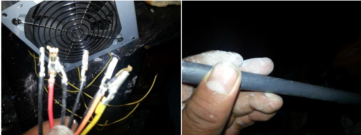
Ilustración 21 : fuente de poder quemada de computadora de la que se saca los cables y a su lado el tubo Berman
