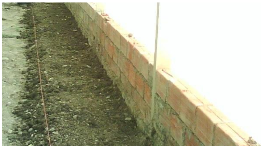
Foto 2. Remoción y nivelado del suelo experimental
