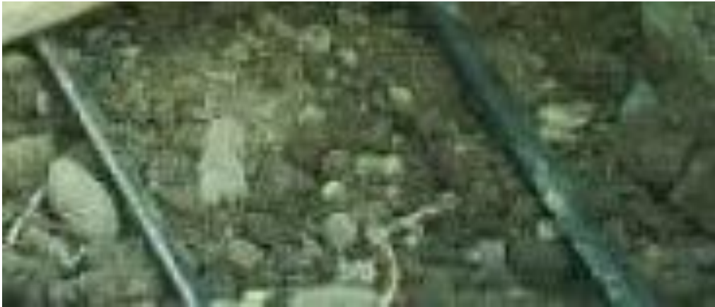
Foto 3. Instalación del sistema de riego por goteo
