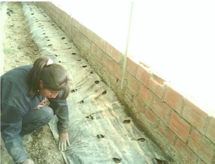
Foto 4. Forado de la platabanda con la cobertura
