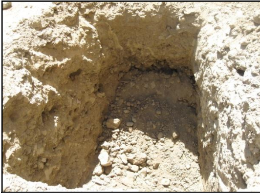
Excavación Pozo n° 1
