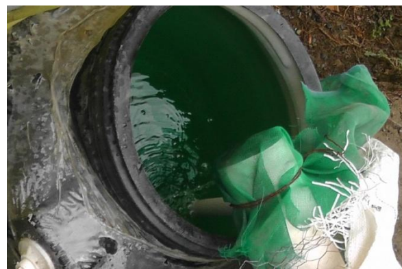
Sistema de drenaje
