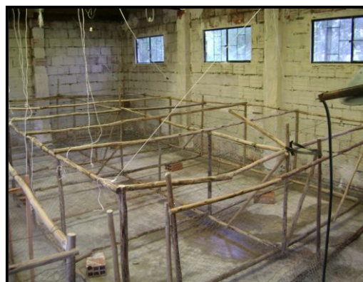
Figura 7. Armado y distribución de jaulas
