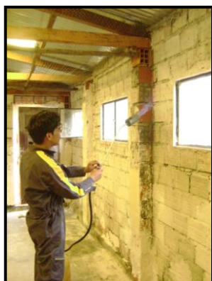
Figura 6. Flameado de paredes
