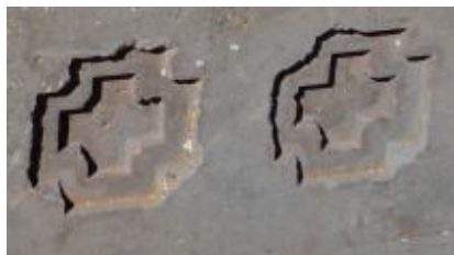
Fotografía 2. Estructura en palacio de Putuni.
