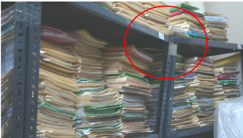
Desestabilización de la estantería por el peso de la documentación en el Depósito Común
