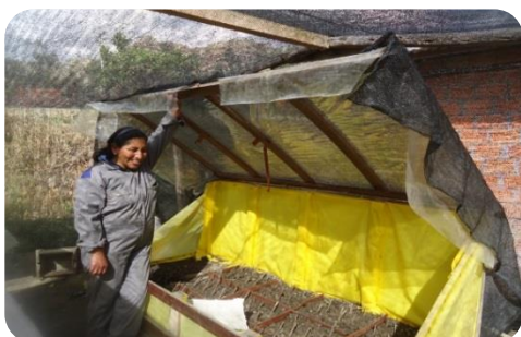
Foto 7: Conclusion de la Cámara de Sub-irrigación
