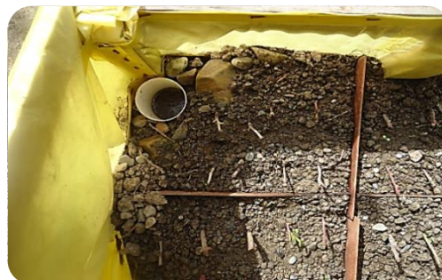
Foto 6: Colocado de tubo para la cámara de Sub-irrigación
