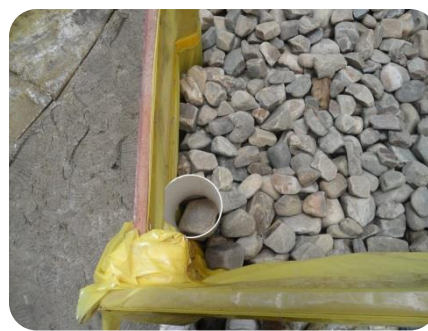
Foto 4: Armado del sistema de sub-irrigación
