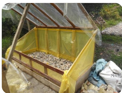
Foto 3: Construcción y armado de las cámaras de sub-irrigación
