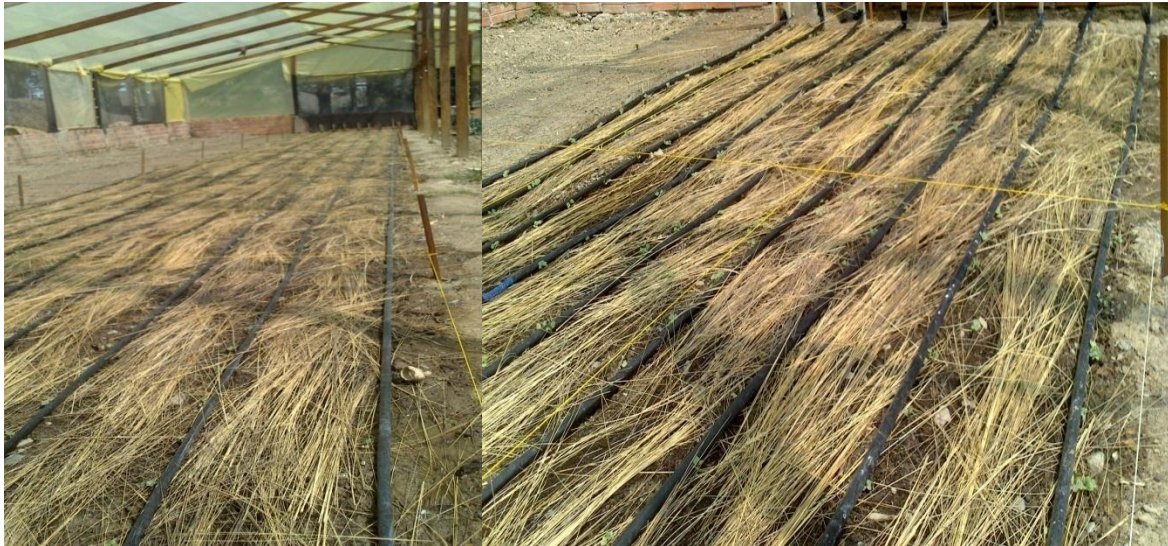
Figura 6. Preparado de surcos e instalación de riego por goteo
