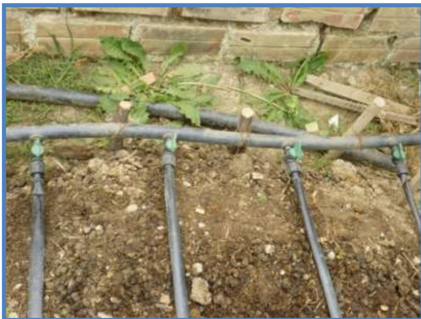
Cuadro 36. Fotografía de la instalación del riego por goteo
