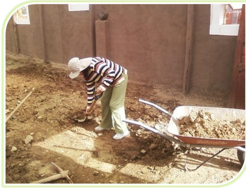
Anexo 11. Realización del cavado de 30 cm
