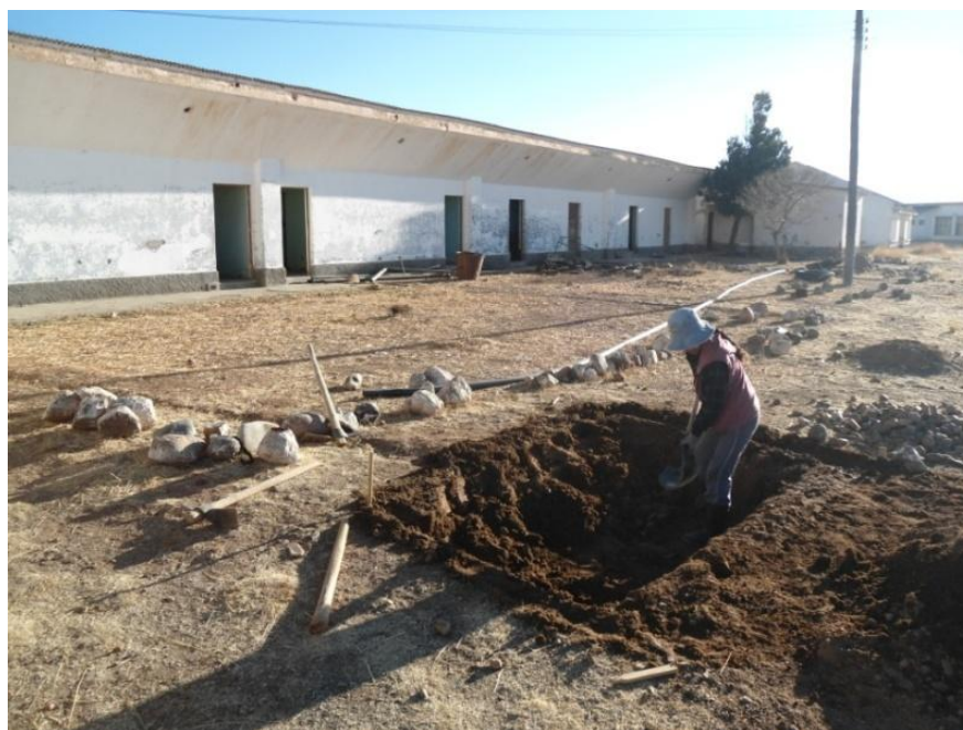
Figura 3. Humedecido y excavado del área de emplazamiento del pankar-huyu.
