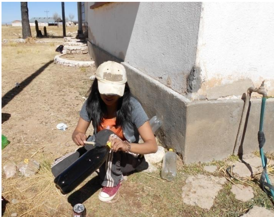
Figura 20. Pintado de botellas pett, para reducir las temperaturas mínimas
