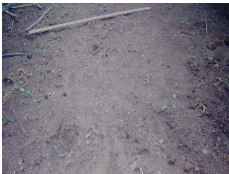
Figura 5. Preparación del terreno
