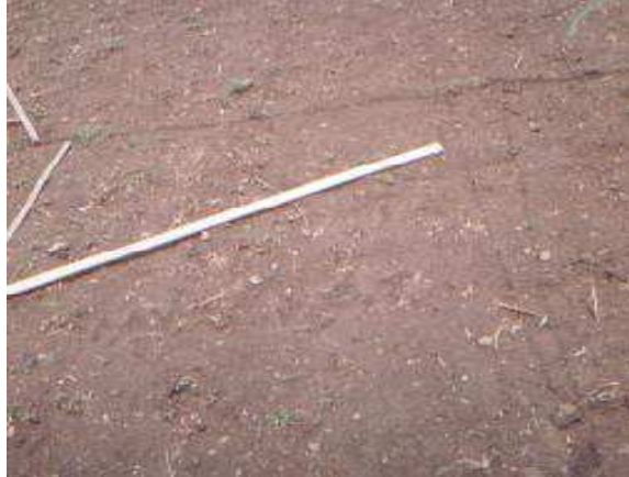
Preparación de terreno
