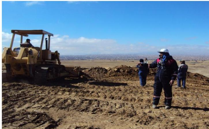
**Fotografía 11:** Nivelación y perfilado del sector “C” del RSVI.
