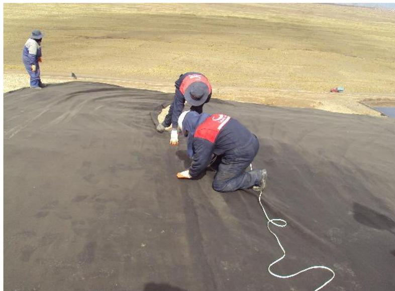
**Fotografía 13:** Aplicación y soldado del Geotextil
