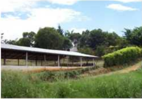
Fotografía 3. Vista exterior del galpón pintado con látex.
