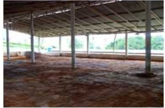
Fotografía 2. Techado con calamina el galpón.
