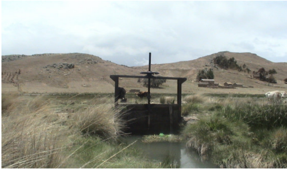
Compuerta derivadora del sistema de riego No 9 (comunidad de Putuni)
