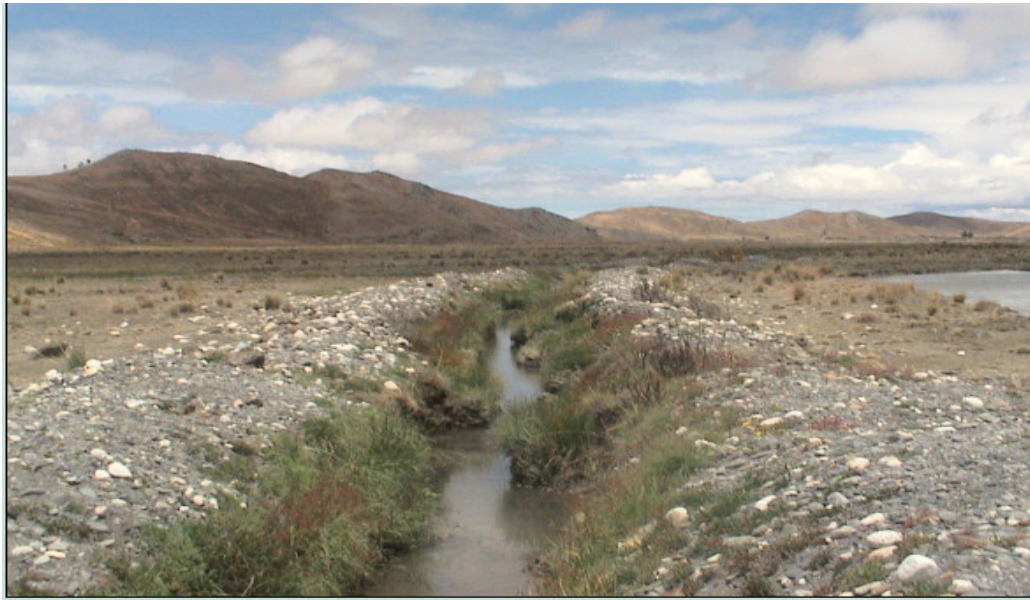
Canal principal del sistema de riego No 9 (comunidad de Pajchani Molino)
