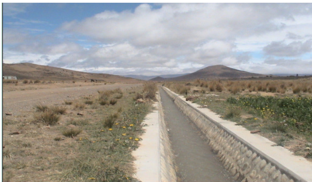
Canal principal mejorado, tipo trapezoidal (Comunidad Pajchani Molino)
