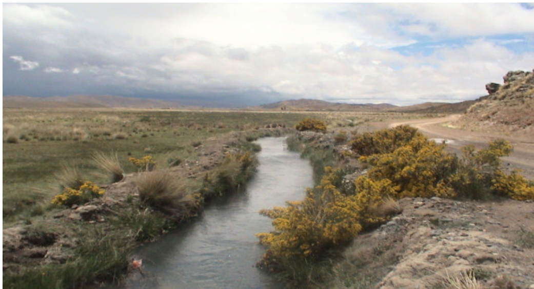
Canal principal del sistema de riego No 9 (comunidad de Putuni)
