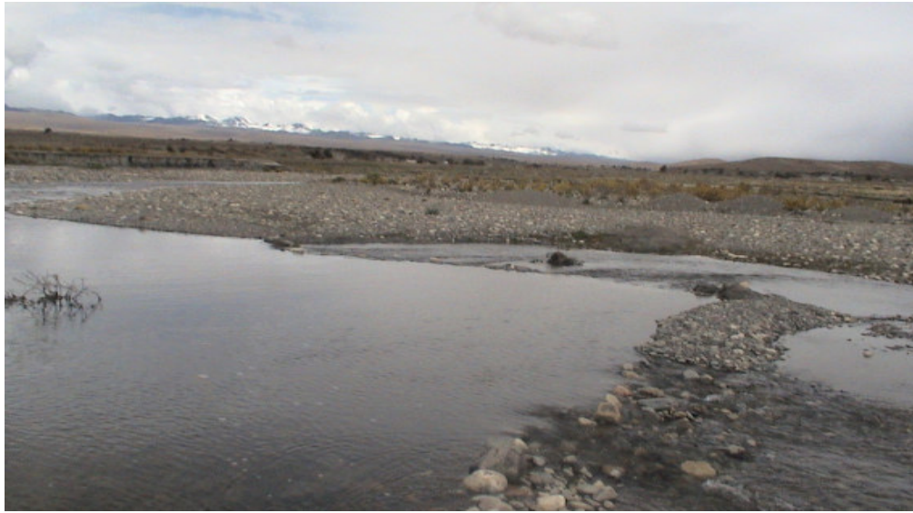
Toma del sistema de riego No 40 (sobre el río Jallps, comunidad Cala Cala)
