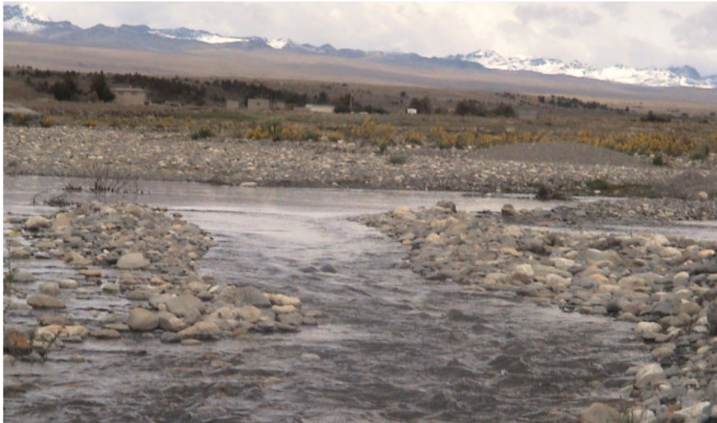
Toma del sistema de riego No 47 (sobre el río Jallps, comunidad Pongon Huyo)
