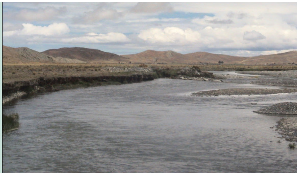
Toma del sistema de riego No 9 (sobre el río Keka, comunidad Pajchani Molino)
