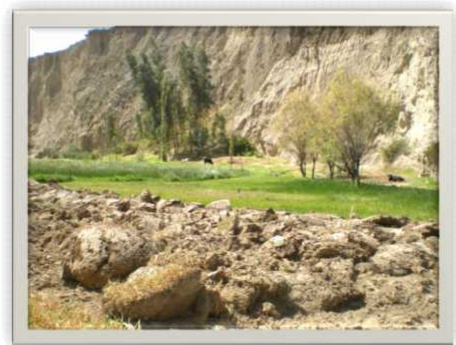
Foto 3. Preparación del Terreno
