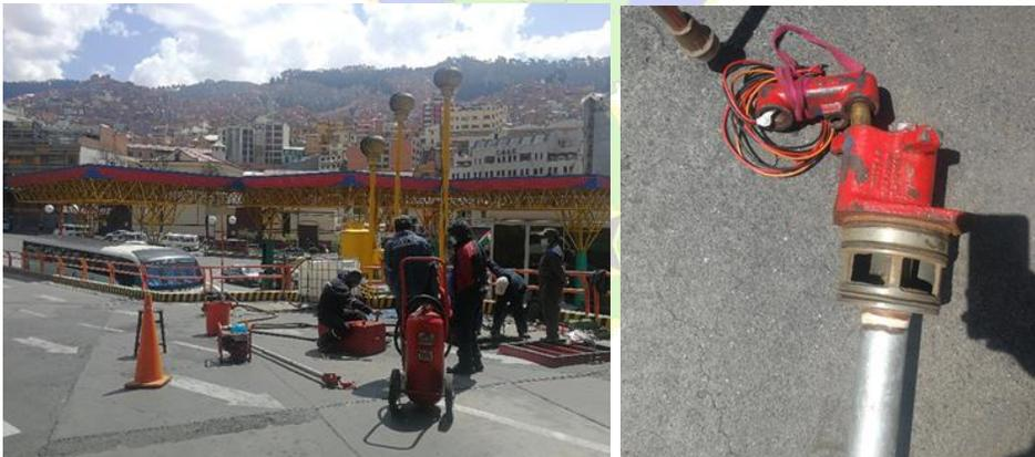
Se debe realizar la revisión de válvulas, mangueras, detectores de fugas, y sistemas eléctricos para asegurar su correcto funcionamiento. Cualquier pieza defectuosa o que presente desgaste debe ser reemplazada de inmediato.
