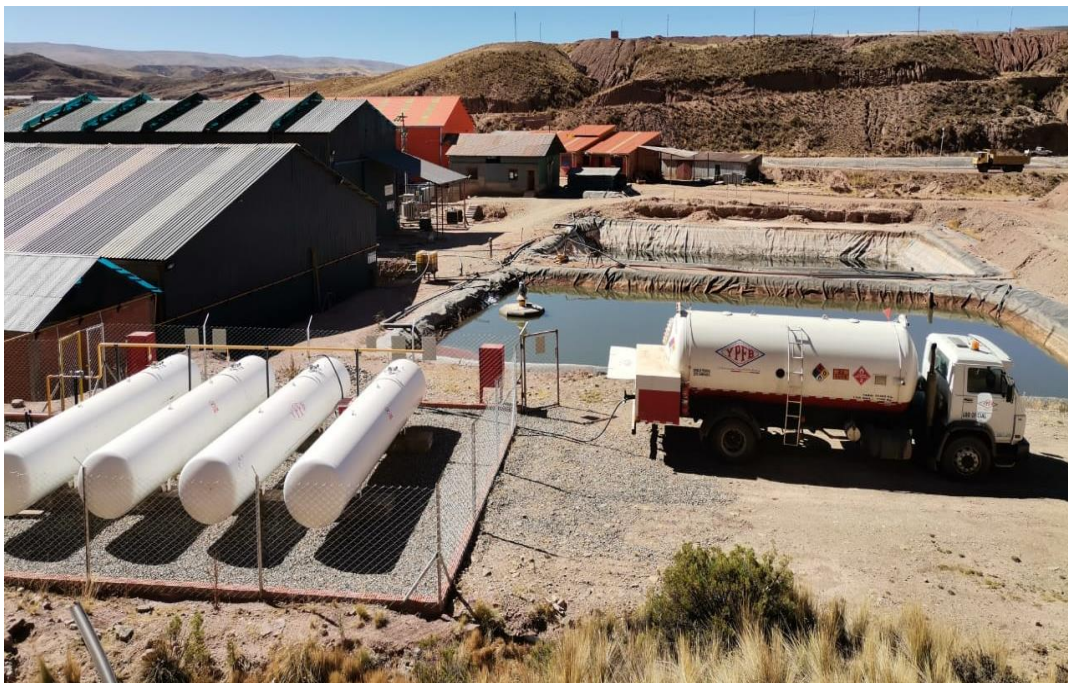
Figura 4.3. Recarga de cliente Industrial
