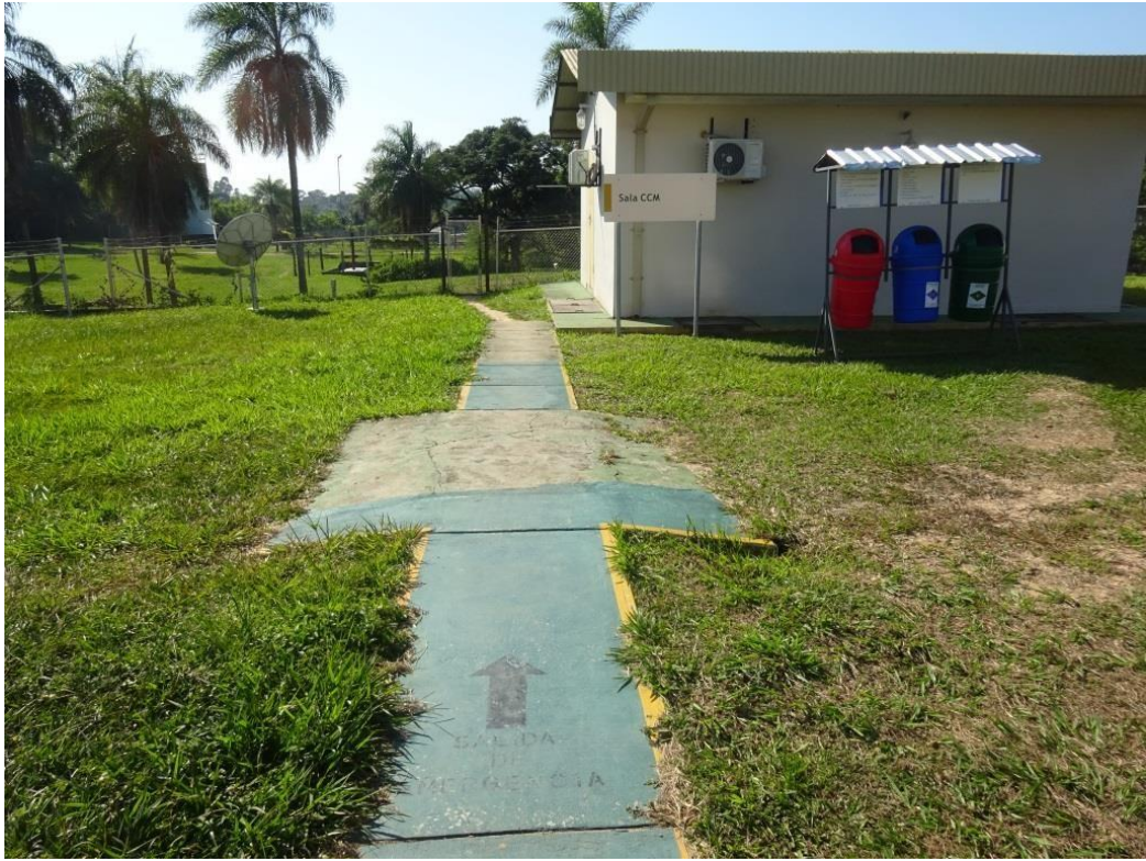
Tercera vía de escape hacia la Planta de Inyección de Agua
