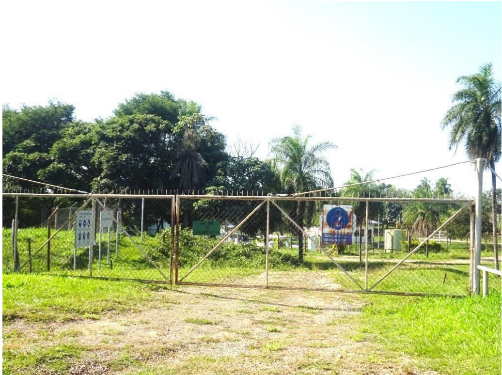
Quinta vía de escape: Puerta de ingreso camiones cisterna
