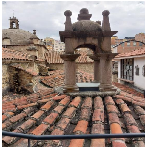
FOTO: LINTERNILLA DEL TECHO DE LA IGLESIA
