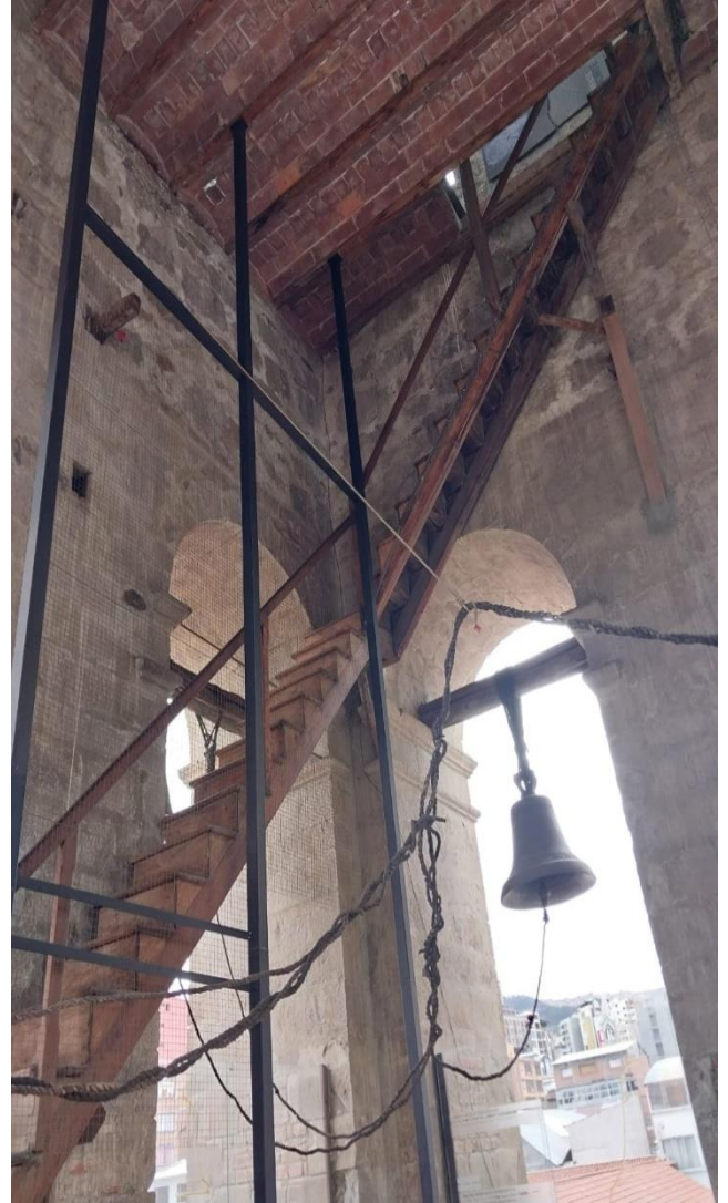
FOTO: ESCALINATAS PARA SUBIR PARTE SUPERIOR DEL CAMPANARIO
