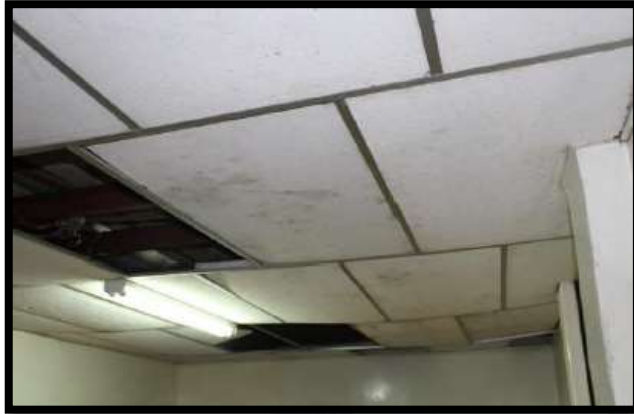
TECHO DEL CUARTO DE ALMACENAMIENTO DE INSUMOS.
