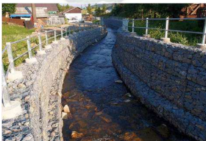
Figura 20. Muro gavión en ríos
