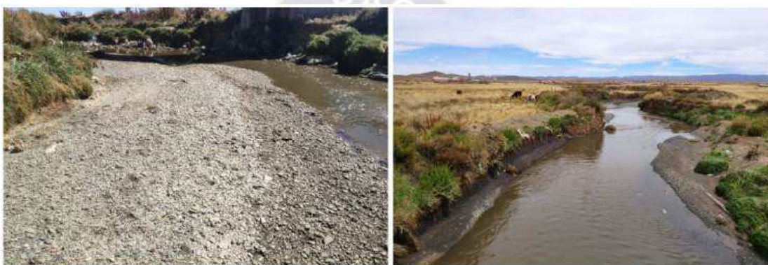
Fotografía 12. Materiales en el cauce principal y llanura de inundación
