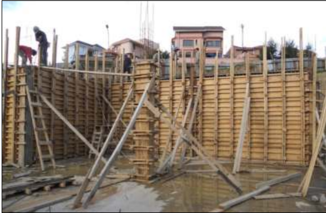
Figura No. 18 Encofrado de columnas y muros.
