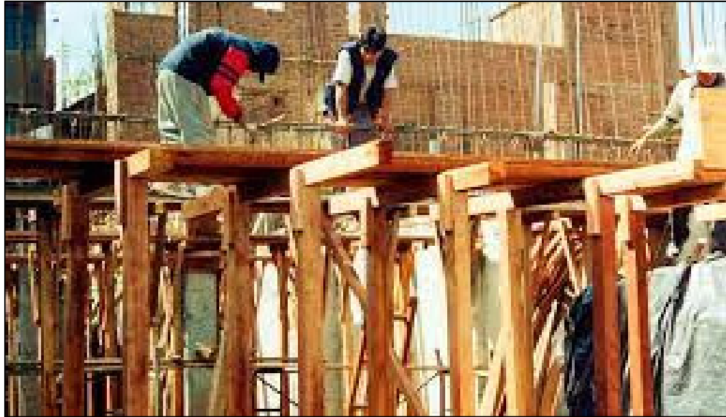
Figura No. 19 Encofrado de losa.
