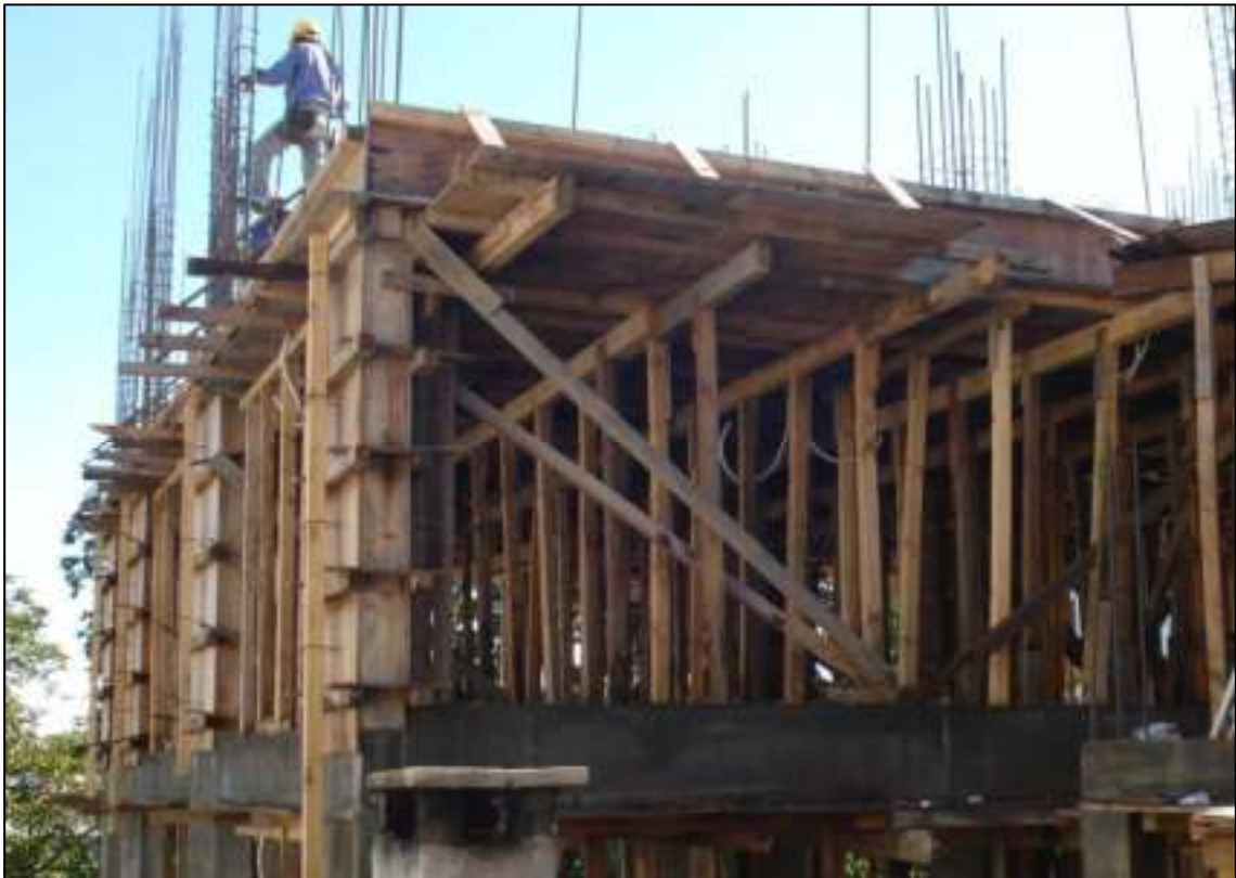
Figura No. 2 Encofrado de madera de una edificación.
