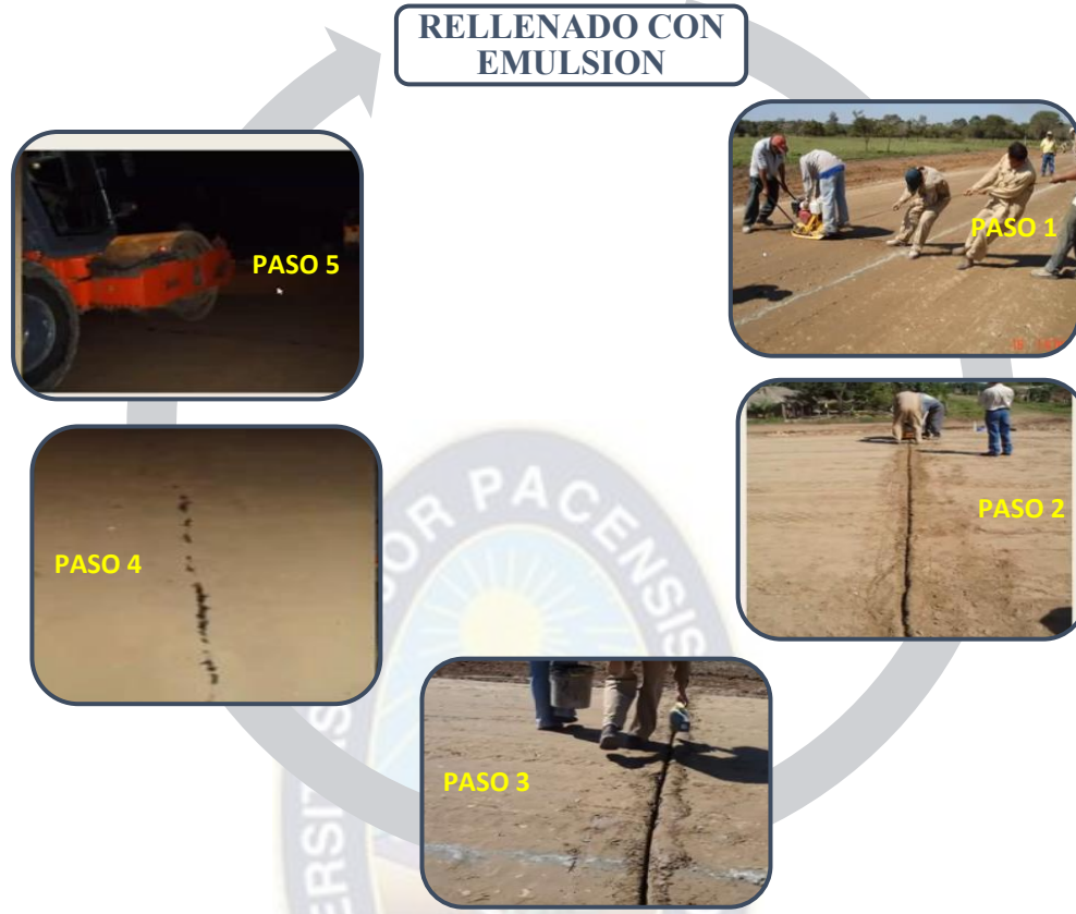
Figura 28. Proceso de una de las alternativas de prefisuración Fuente: Elaboración propia
