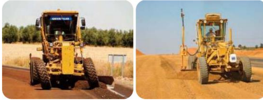
Figura 30. Refino y nivelación con motoniveladora
