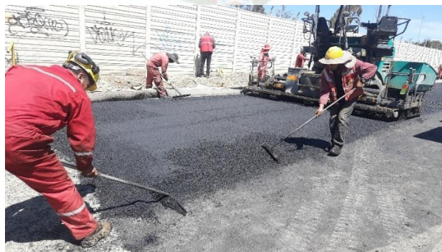
Figura 4. Pavimento Flexible Fuente: (2023), Elaboración propia
