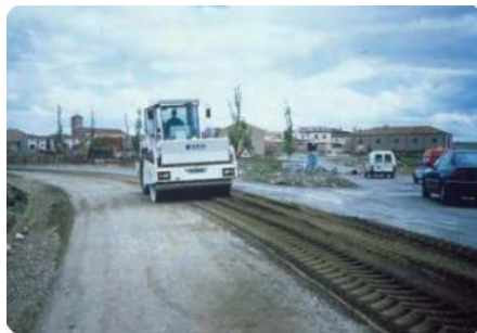
Figura 29. Compactación de un tramo Fuente: Ing. Roger Flores Laura, (2016), Reciclado de Pavimentos Flexibles con Cemento - IBCH
