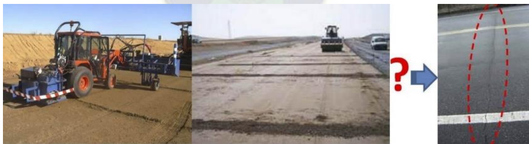
Figura 27. Prefisuración de juntas tras terminar el reciclado
