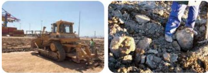
Figura 23. Preparación de la superficie existente antes del reciclado
