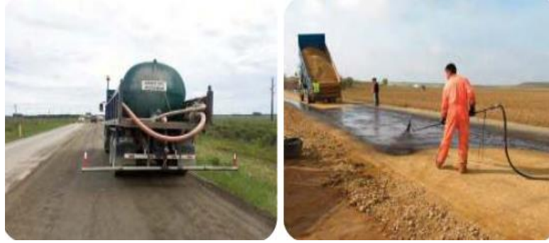
Figura 31. Curado con agua y lanzade emulsión de una pequeña superficie Fuente: Jesús Díaz Minguela y Miguel López Bachiller, (2018), Reciclado de Firmes In-Situ con Cemento
