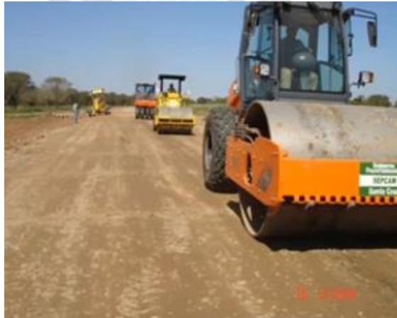
Figura 20. Compactado con rodillo liso
