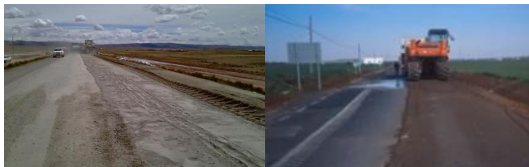
Figura 26. Trabajo de reciclado por carril
