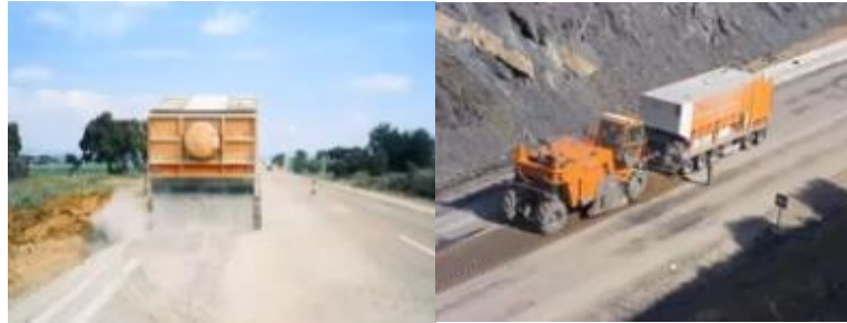
Figura 24. Extensión de cemento en forma seca y húmeda
