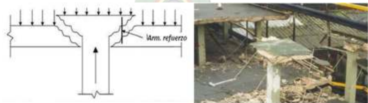
Figura 3.36. Falla característica por Punzonamiento
