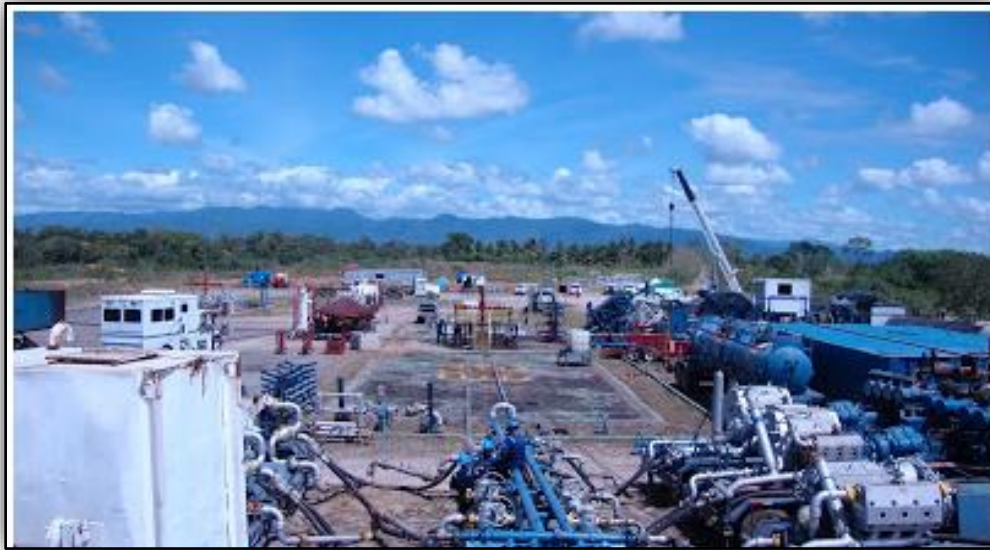
Figura 2.29 Armado de líneas
