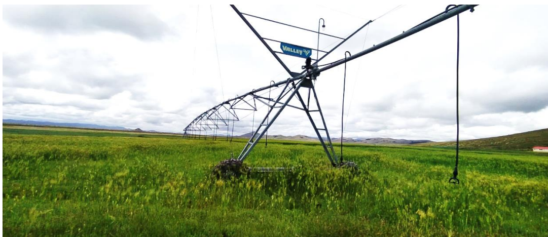
Figura 2. Torre de conducción
