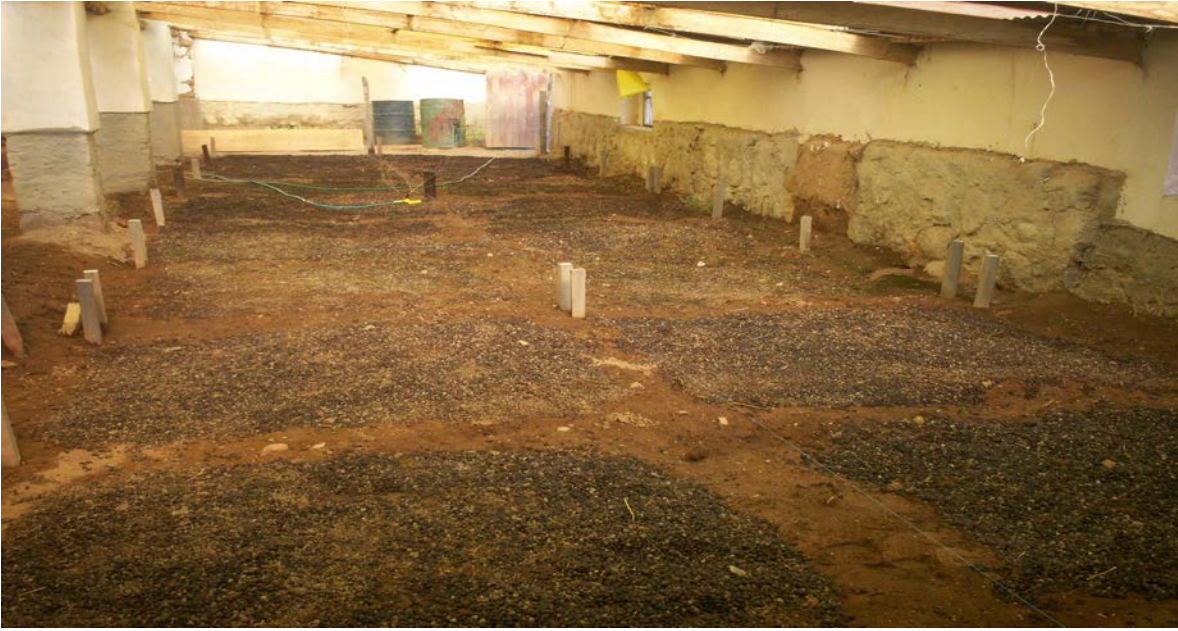
Figura 4. Preparación del terreno
