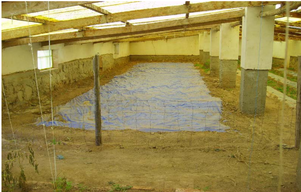
Figura 3. Desinfección del suelo
