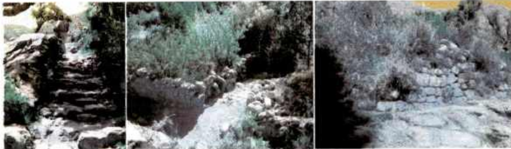
ILUSTRACION N. 93: SENDEROS EMPEDRADOS CON PAREDES INCAS
