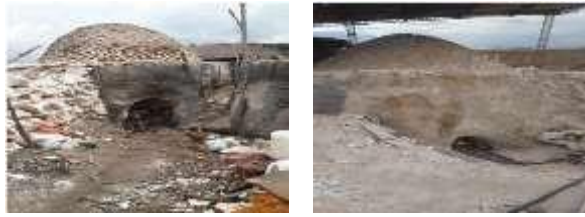
Figura 5 Hornos de calcinación a leña y gas empresa MhalexTec - Cochabamba. Fuente. Productora de yeso MhalexTec.
